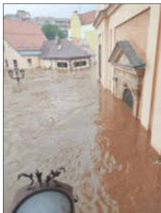
Der Kircheneingang war fast zwei Meter überflutet.
